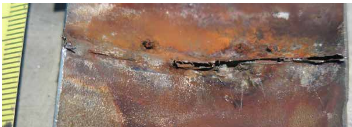
Slika 6: Snimka izrezanoga ispitnog uzorka zavarenog spoja s vidljivim neprovarom korijena zavora, korozijskim oštećenjima i talogom korozijskih produkata
