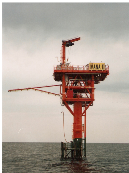
▲ Proizvodna platforma Ivana D (monopod konstrukcije) na plinskom polju Ivana
