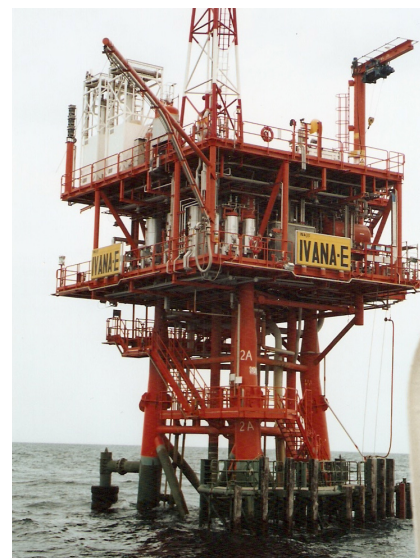
▲ Proizvodna platforma Ivana E (rešetkaste konstrukcije s više nogu) na plinskom polju Ivana
